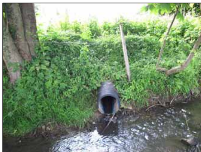
Photographie 17 : rejet au niveau de la cave coopérative d'Azé
