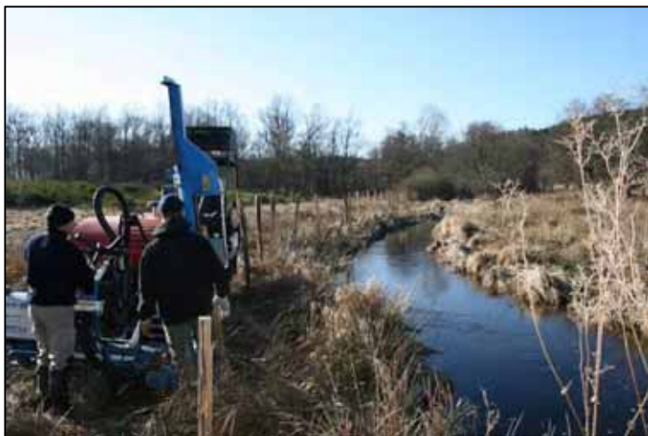
Photographie 29 : plantation d'une clôture en bord de cours d'eau (Sources : LIFE 04NAT/FR/000082)
