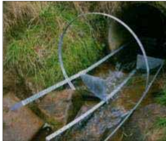
Photographie 32 : Implantation de petits seuils dans une buse (Sources : LIFE 04NAT/FR/000082)
