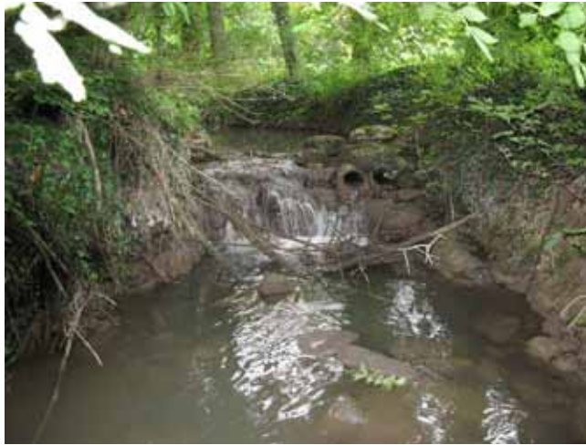
Photographie 30 : exemple d'un seuil pouvant être facilement arasé (seuil sur le ruisseau de Fissy à Lugny)
