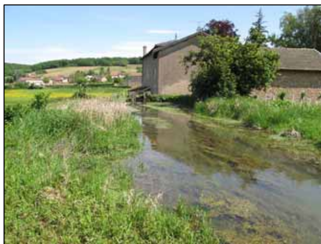
Photographie 10 : retenue d'eau sur le Talenchant en amont du barrage du Moulin de Vanzé à Verzé
