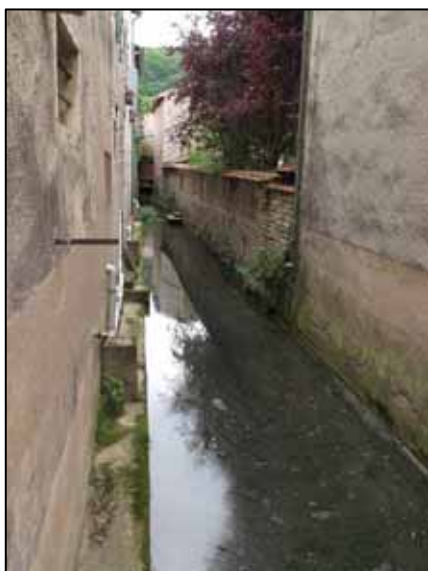
Photographie 23 : Lit et berges du ruisseau de Bissy bétonnés dans le Bourg de Lugny
