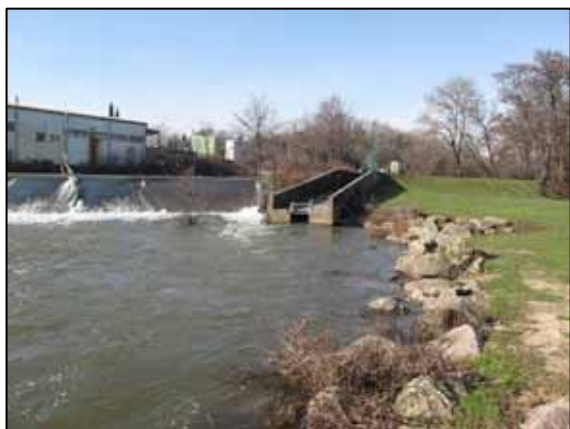
Photographie 33 : passe à poissons sur l'Arroux à Gueugnon
