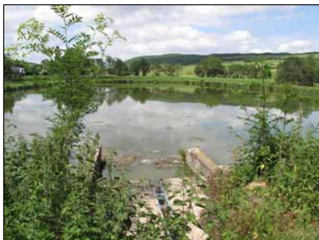
Photographie 18 : lagunage d'Azé visiblement mal entretenu (cloison syphonée hors service) et recevant des effluents vinicoles en période de vendange
