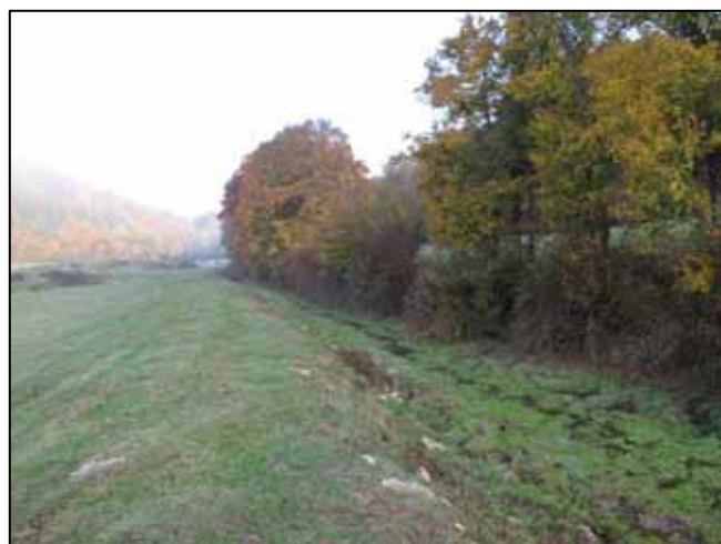
Photographie 34 : exemple d'un tronçon de cours d'eau dévié, présentant aujourd'hui un habitat très pauvre : la Bourbonne à Cruzille
