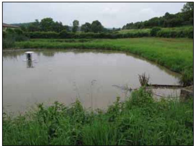
Photographie 5 : Lagunage de Chevagny - "Lotissement" à proximité du Moulin Journet visiblement mal entretenu (taille des bassins réduite, cloison syphoïde hors service, ...)
