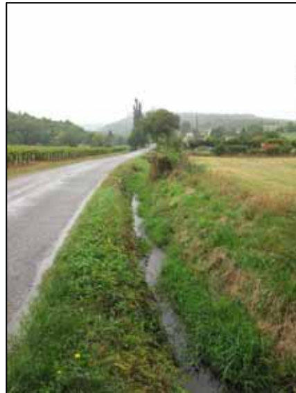
Photographie 8 : tronçon rectifié de la Denante le long d'une route en amont de Davayé
