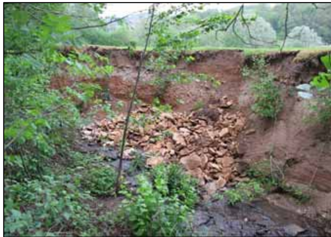
Photographie 14 : incision forte du lit de la Petite Mouge en aval de la dérivation de la carrière d'Igé
