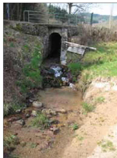
Photographie 25 : Chute d'eau en aval du pont de la D 211 à Matour sur le ruisseau des Etiveau :
