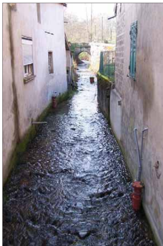
Photographie 14 : Le lit du Pelot artificialisé dans Saint Pierre le Vieux :
