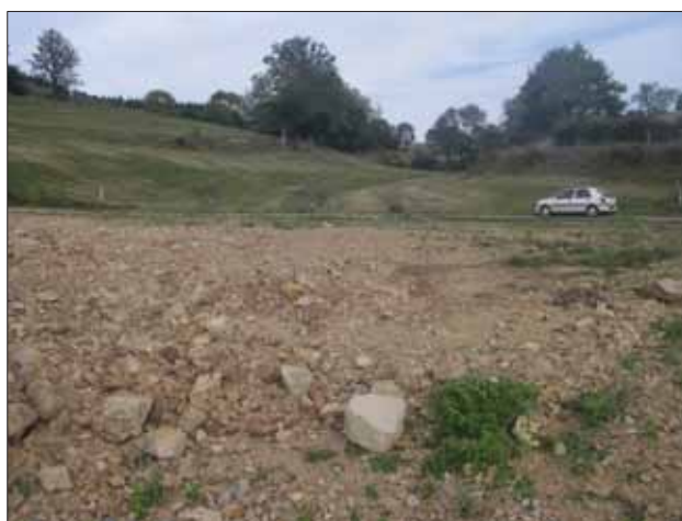
Photographie 19 : Remblai du ruisseau du Loire :
