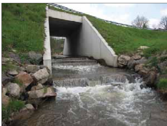
Photographie 27 : Aménagement de bassins successifs sur la Toule en aval du pont routier de la D987 à Trambly :
