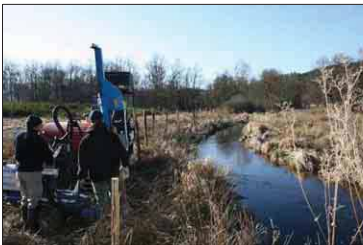
Photographie 20 : plantation d'un clôture en bord de cours d'eau (Sources : LIFE 04NAT/FR/000082)
