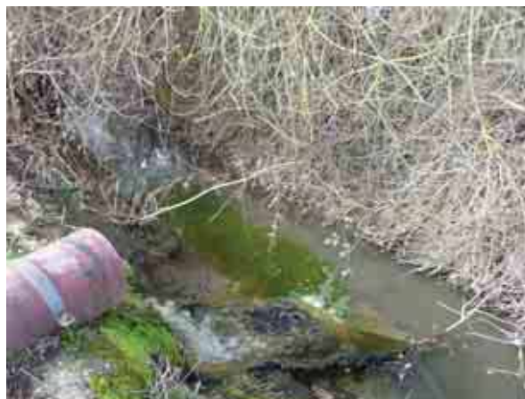
Photographie 10 : Rejet du lagunage de Mercurey dans le Giroux
