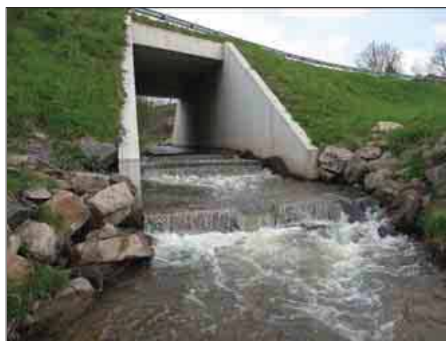
Photographie 22 : Aménagement de bassins successifs réalisé en Saône-et-Loire sur la Toule (bassin de la Grosne) à Trambly
