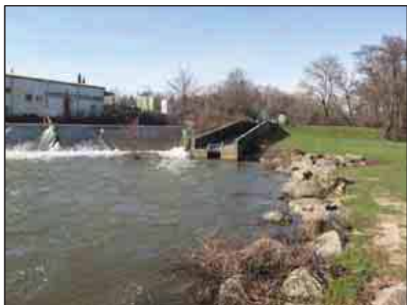
Photographie 24 : passe à poissons sur l'Arroux à Gueugnon
