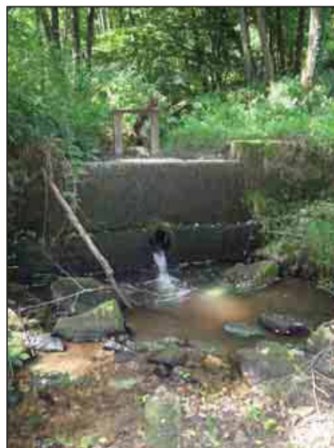
Photographie 21 : Seuil sur l'Orbize à « Theurey » (BARIZEY) qui pourrait être arasé
