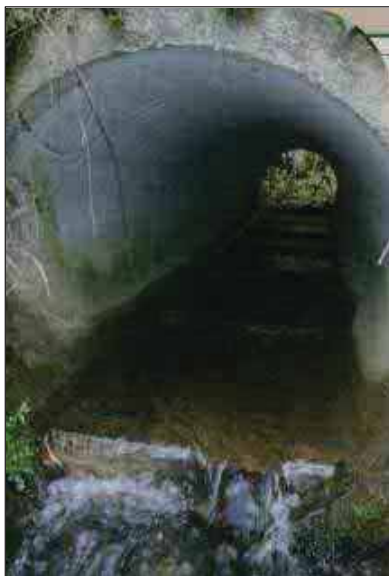
Photographie 23 : Implantation de petits seuils dans une buse (Sources : LIFE 04NAT/FR/000082)
