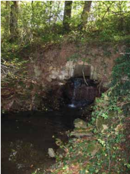
Photo n° 12 : Système de vidange de l'ancien étang des Argolets constituant aujourd'hui un obstacle infranchissable.
