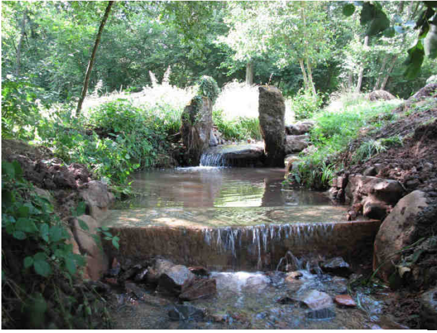
Figure 8 : Un pré-barrage (au premier plan) a été créé pour partager la hauteur de chute du seuil en deux, et ainsi faciliter le passage des truites
