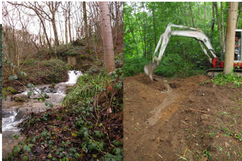
Figure 6 : Une chute infranchissable Figure 5 : illustration des travaux : la située au bout du bief de dérivation est Mouge retrouve son lit naturel désormais contournée
