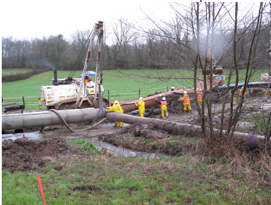
Photographie 12. Travaux d'implantation de la conduite de Gaz « Artère du Mâconnais » sur la Mouge
