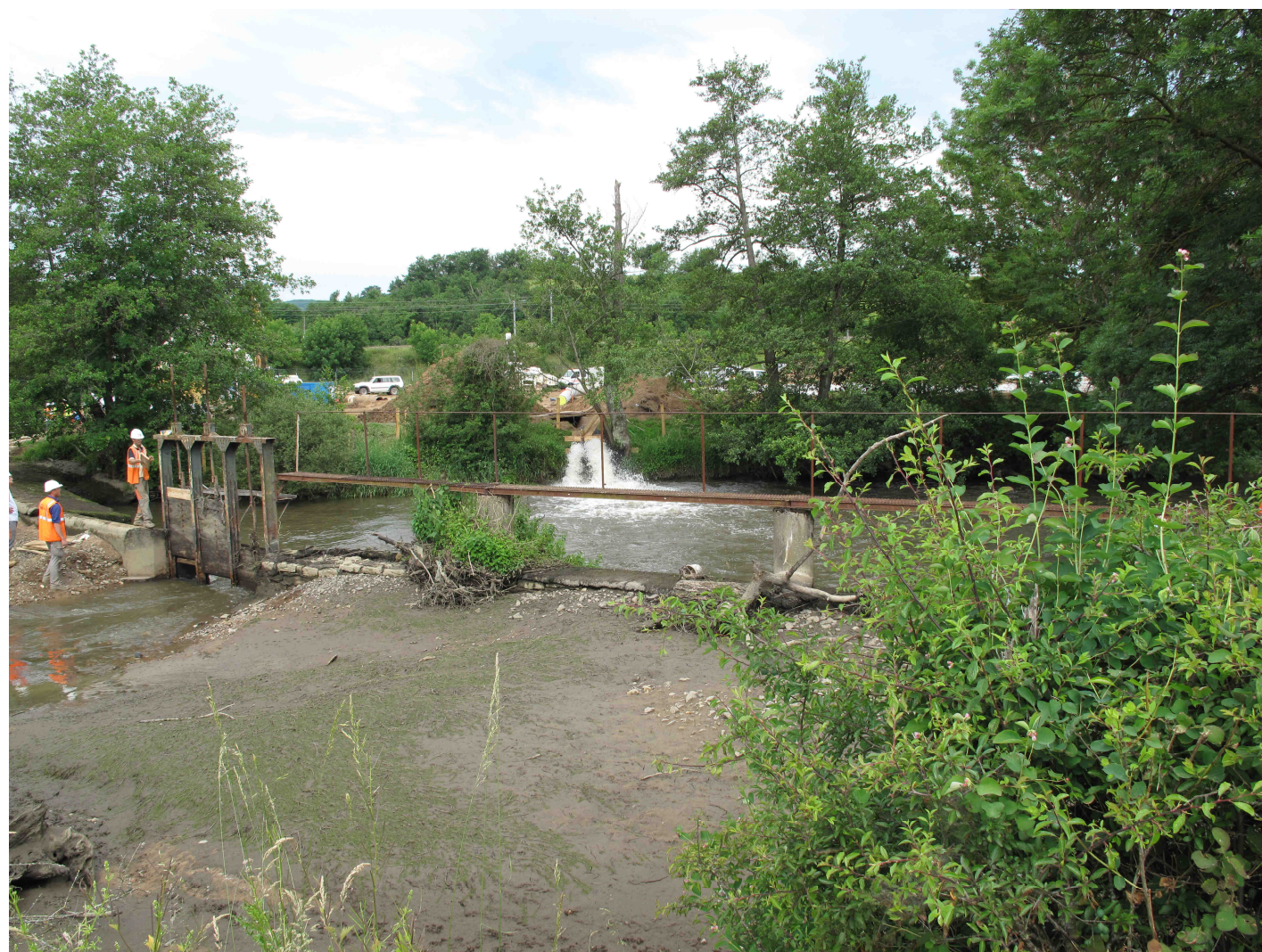
Photographie 14. La Grosne pendant la phase travaux
