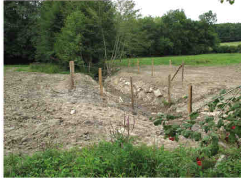
La Mouge quelques mois après la phase de travaux (2010)
