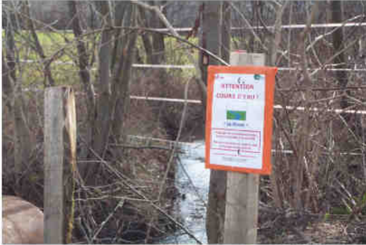
La Mouge pendant la phase de travaux (2009)
