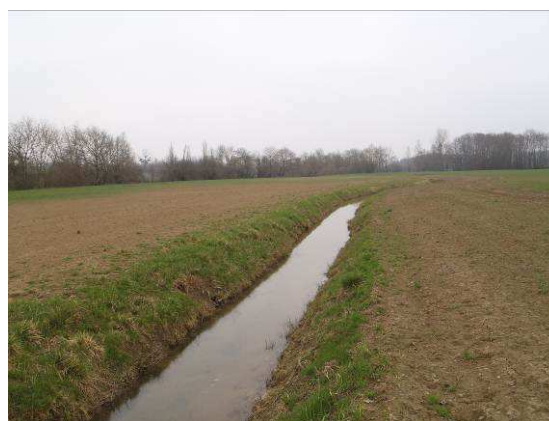
Photographie 9 : Fossé du Creuillet à Frontenaud (site °13)
