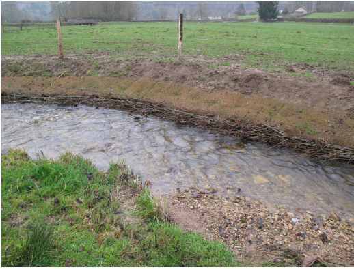
Photo : Encoche d'érosion traitée après travaux
