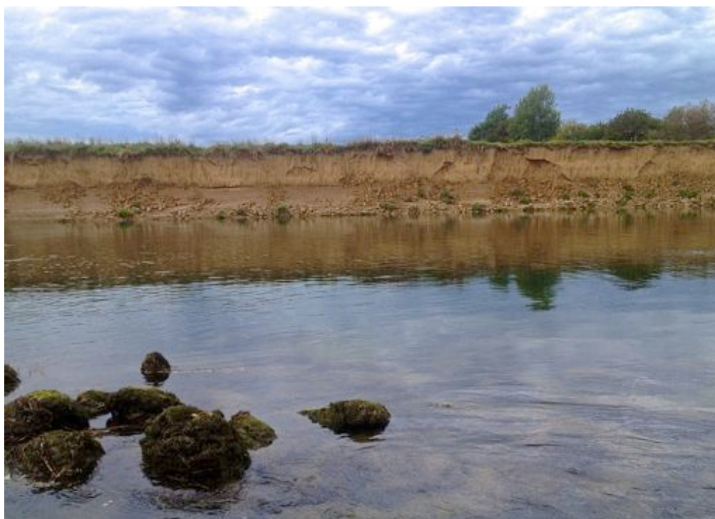
Figure 47. Forte érosion latérale entre Charrette et Longepierre
