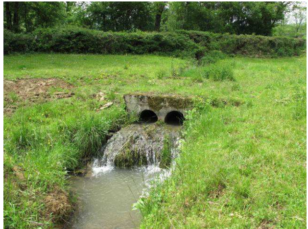
Photographie 2 : buse d'un ponceau agricole à la Chaigne (T5)
