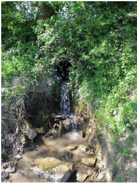
Photographie 3 : Buse sous un chemin (V2)
