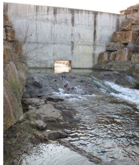
Photographie 6 : seuil du bassin écreteur de crues de Laizé (T19)
