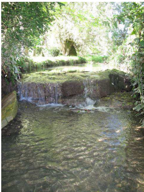
Photographie 7 : barrage de Vanzé (T11)
