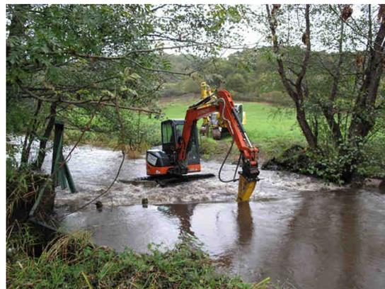
Figure 3 : Effacement du barrage des Camuzeaux
