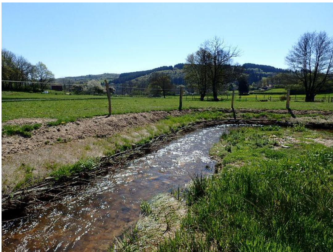
Photographie 9. Berge érodée n°2 après traitement
