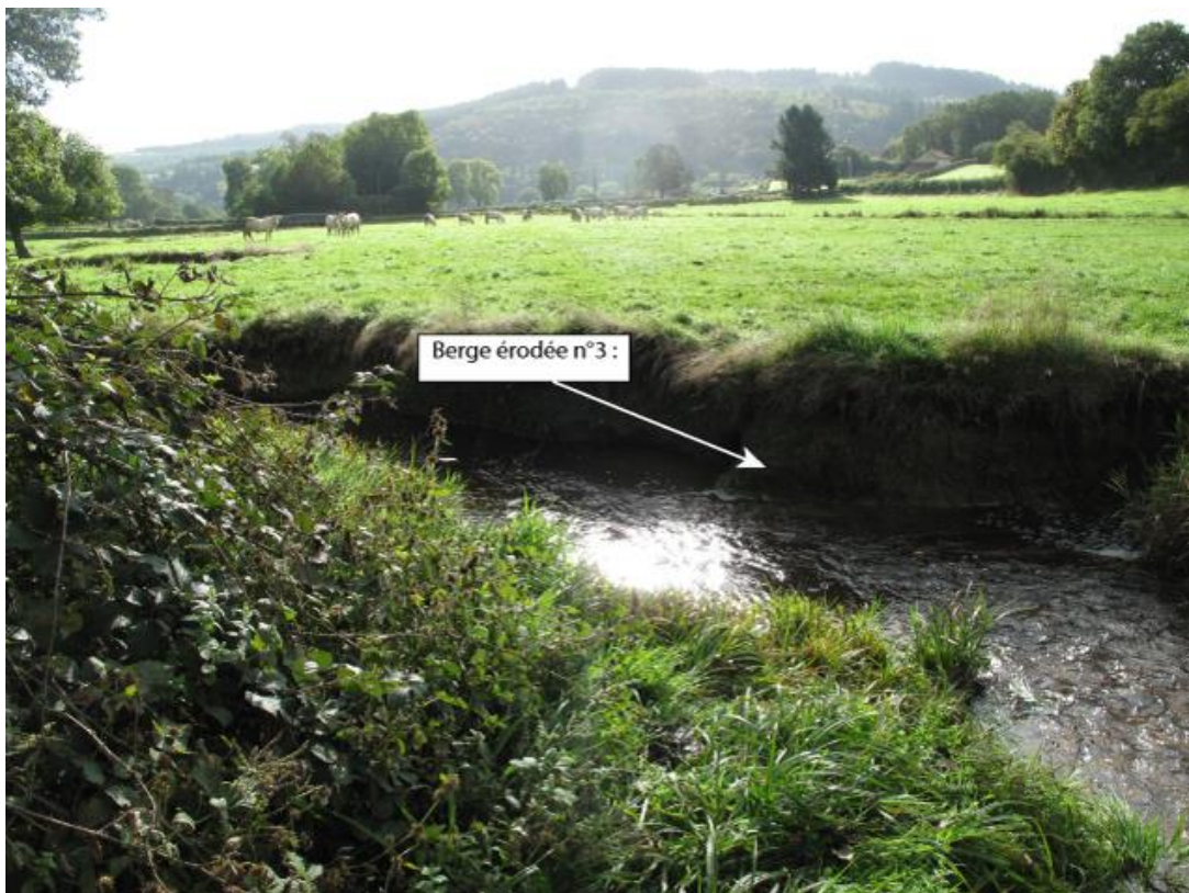
Photographie 10. Berge érodée n°3 avant traitement
