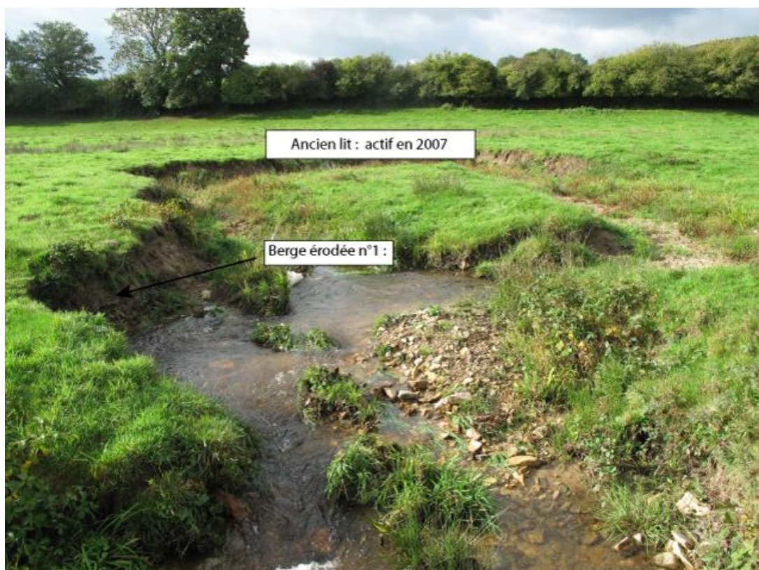
Photographie 7. Berge érodée n°1 avant traitement
