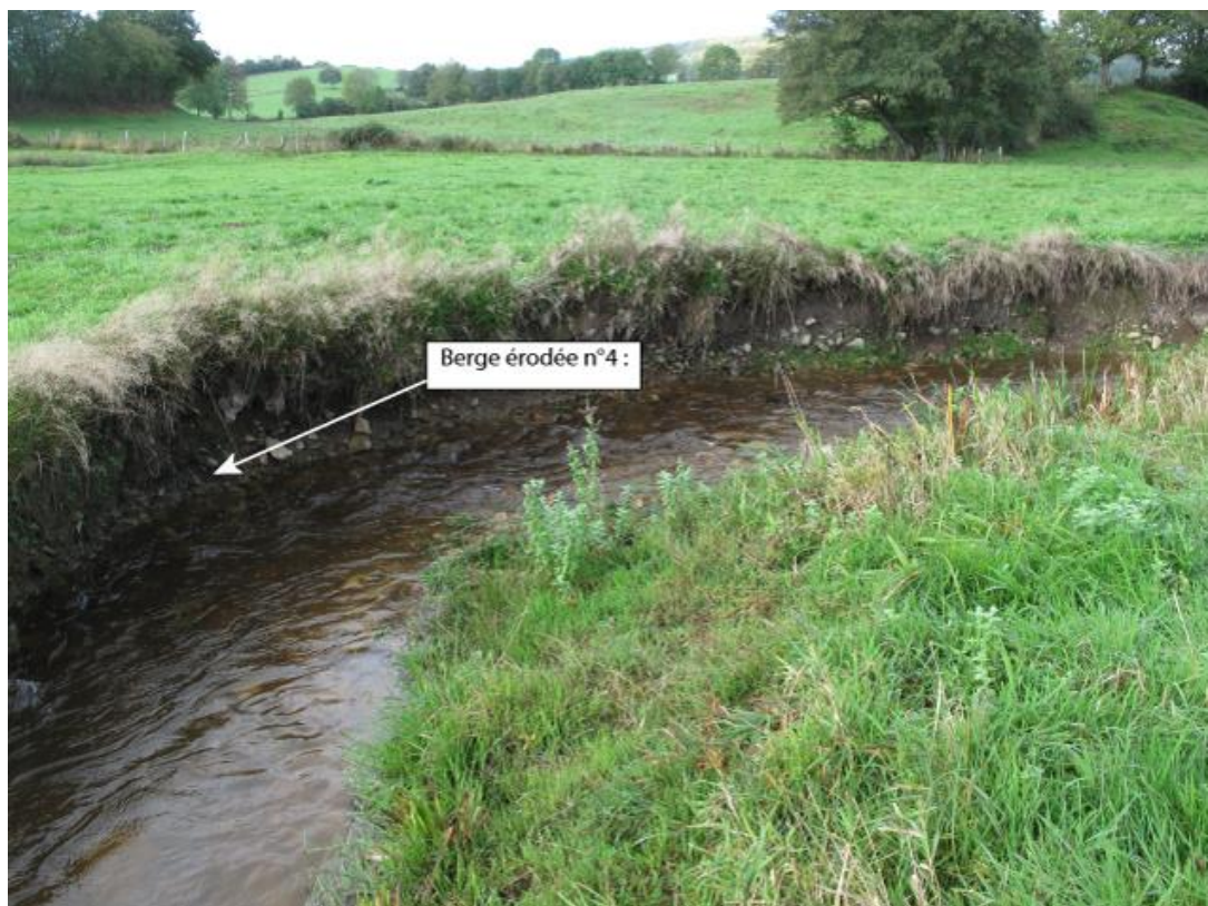
Photographie 12. Berge érodée n°4 avant traitement
