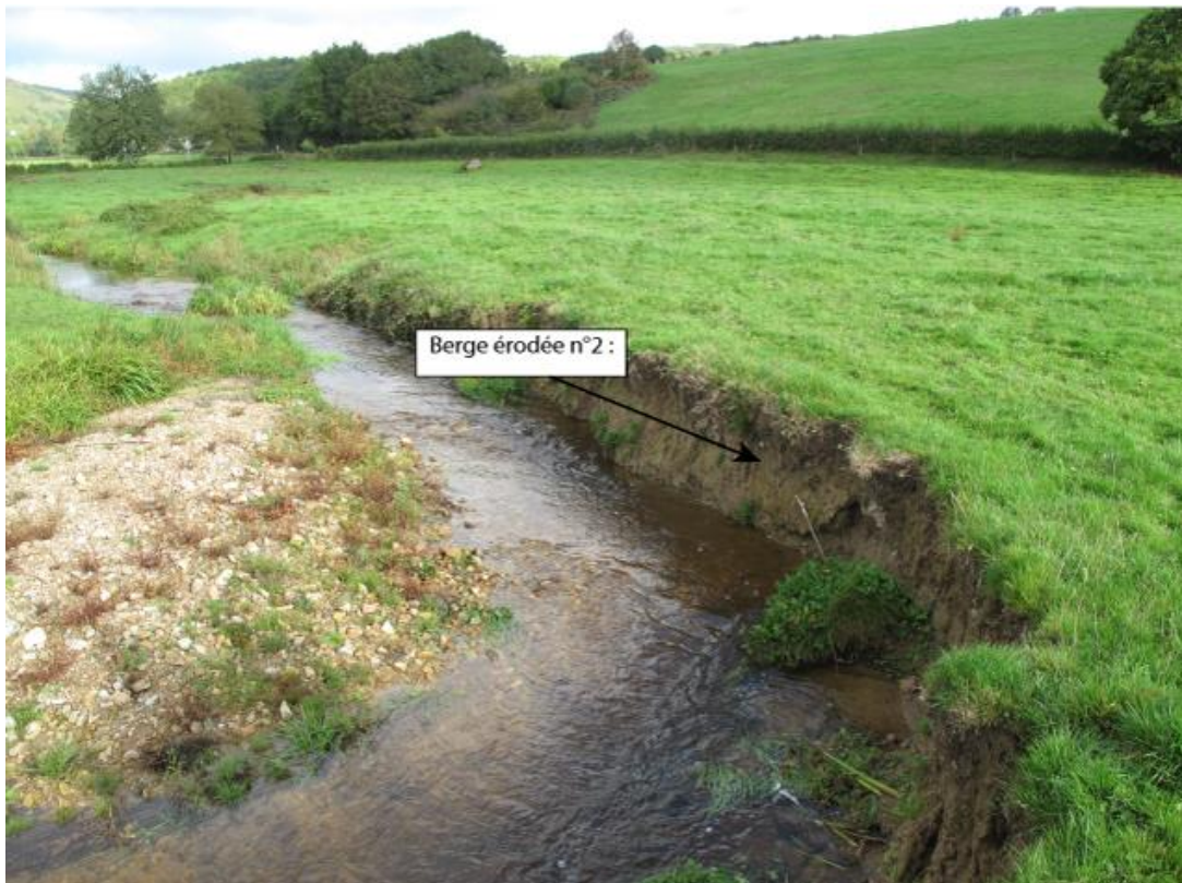
Photographie 8. Berge érodée n°2 avant traitement
