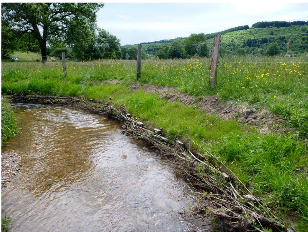
Photographie 11. Berge érodée n°4 après travaux
