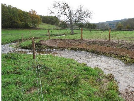
Photo : Encoche d'érosion traitée après travaux
