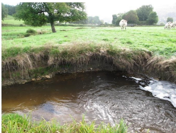
ruisseau des Vernottes – avant travaux
