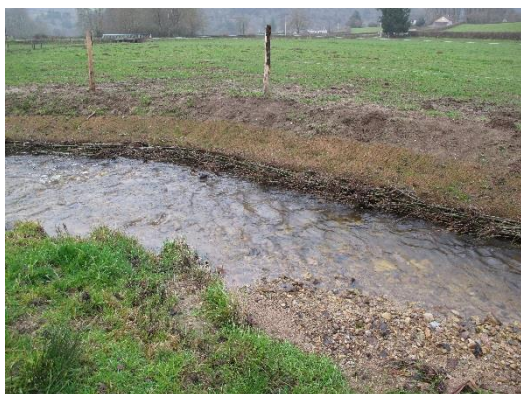
Photo : Encoche d'érosion traitée après travaux
