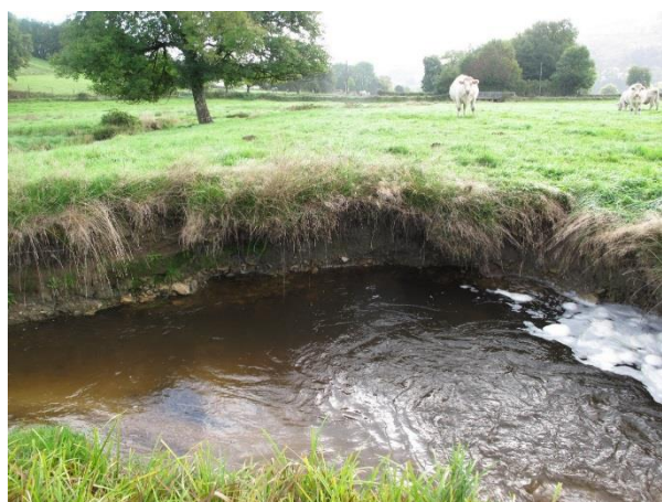
des Vernottes – avant travaux
