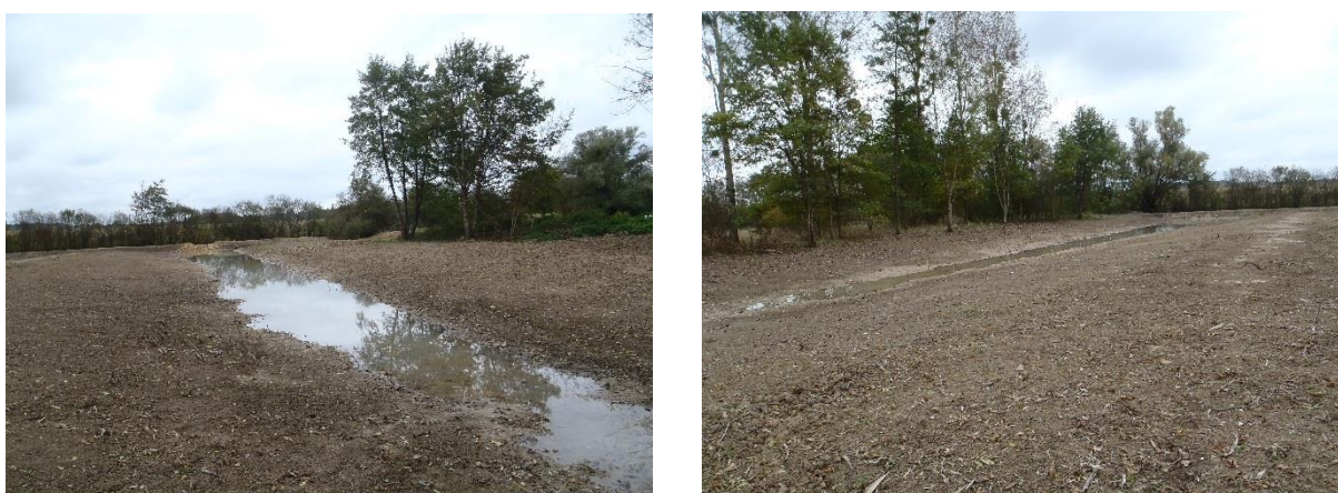
Figure 1 : Frayère de la culée à Sainte-Croix juste après la réalisation des travaux
