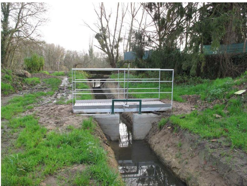
Photographie 2 : un ouvrage de gestion hydraulique permet lorsque les bastinges sont posés d'assurer une submersion de la zone humide suffisante pour permettre les différentes étapes de la reproduction du brochet.
