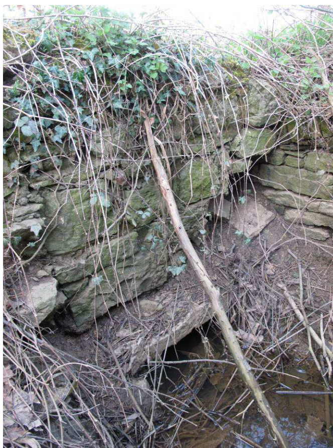
Photographie 3 : Sortie de la buse dans le bief
