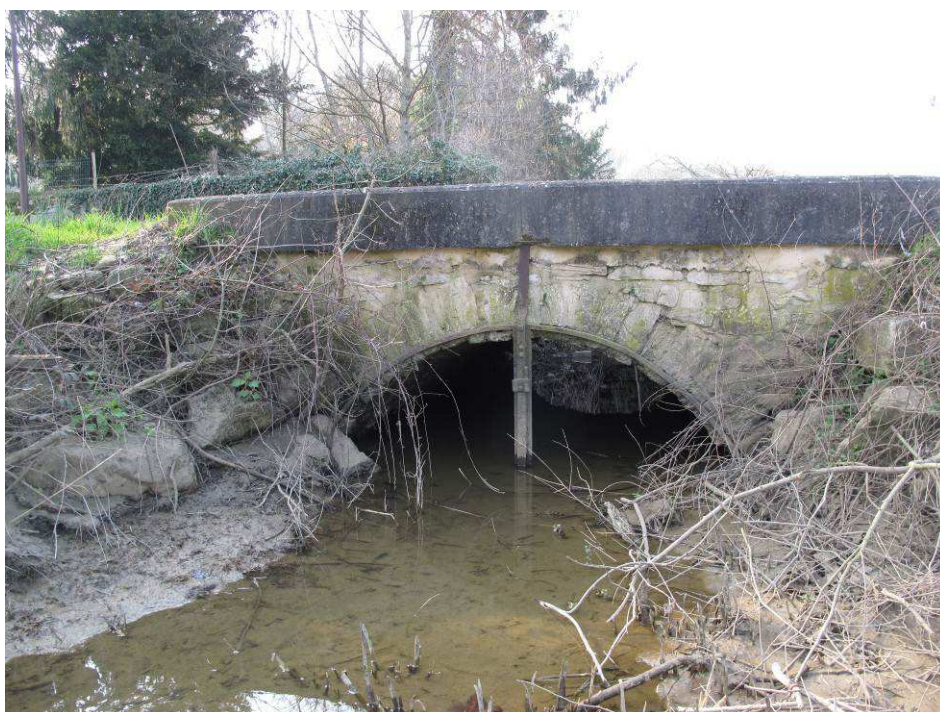
Photographie 4 : vue sur le pont de la voie communale (pas de problème de franchissement piscicole)
