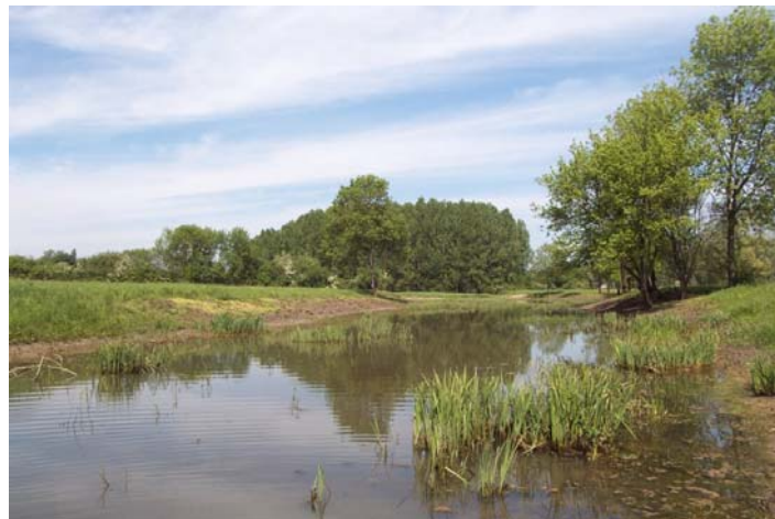
Photographie 6 : baisse de la Culée 1 an après travaux
