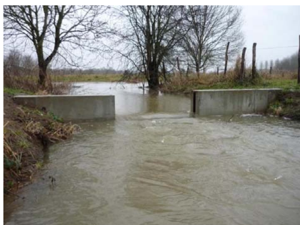
Photographie 10 : Ouvrage du bief Colas le 24 janvier 2009, franchissable par les brochets
