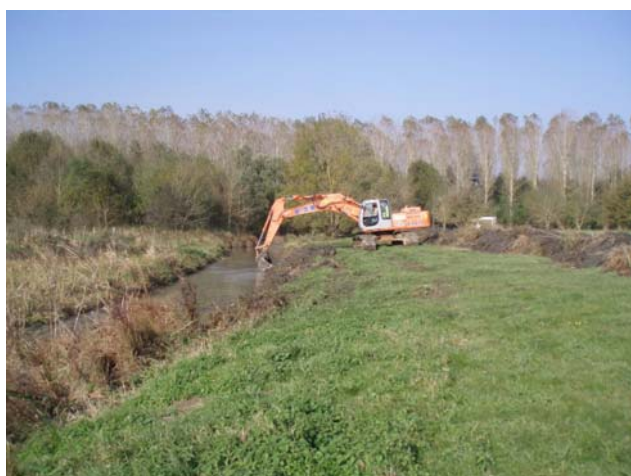
Photographie 3 : arasement d'un atterrissement dans la partie aval du bief Colas
