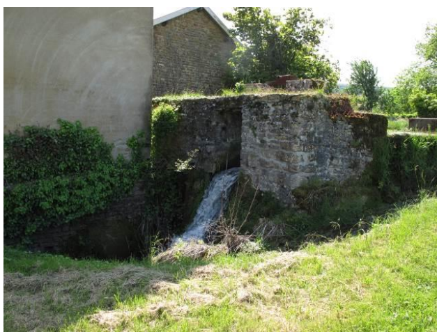
Exemple de seuil pénalisant le déplacement des poissons : seuil du moulin de Verzé
