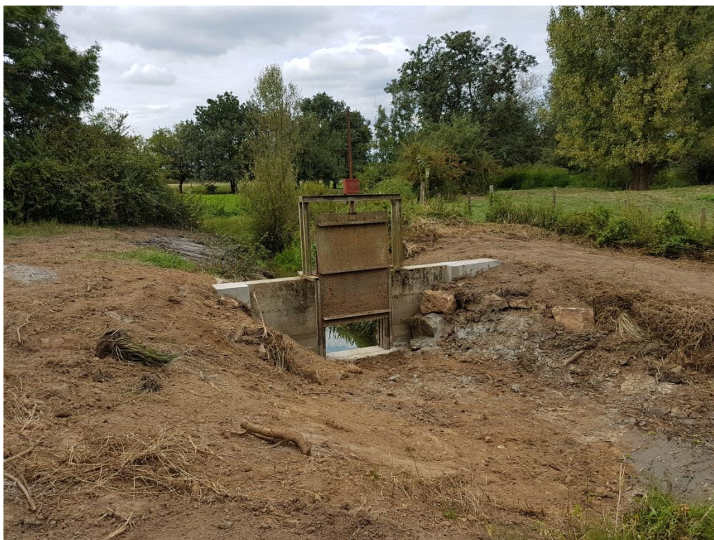
Photographie 2 : vannage après travaux : le secteur en eau devant le vannage a été comblé, la base du vannage réhaussée et les murs latéraux élargis.
