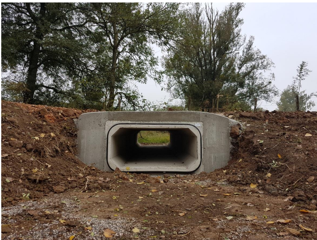
Photographie 4 : Busage installé sous le chemin d'accès qui permet désormais d'assurer la continuité piscicole et hydraulique entre les deux parties du bras mort.
