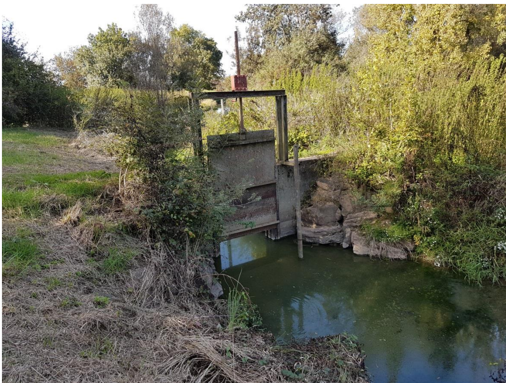
Photographie 1 : vannage avant travaux (en période de basses eaux)
