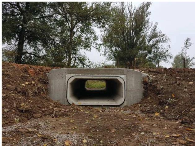
*Busage installé sous le chemin d'accès pour faciliter les déplacements du poisson au sein du bras mort*
