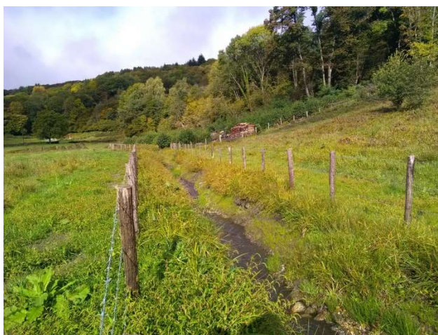
Le ruisseau des Vernes de Lyre après travaux : cette portion était jusqu'en 2018 couverte par un long busage
