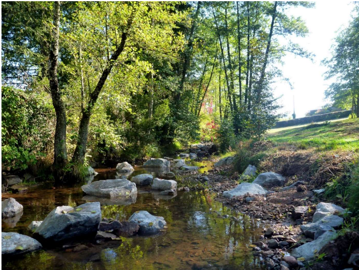
Blocs nouvellement posés dans le lit du Botoret
