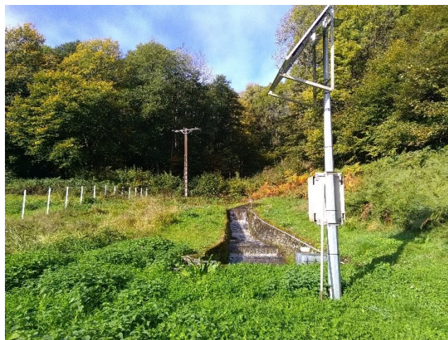
PHOTOGRAPHIE 1 : OUVRAGE DE PRISE D'EAU IMPLANTE SUR LE RUISSEAU DES VERNES DE LYRE A BROYE
