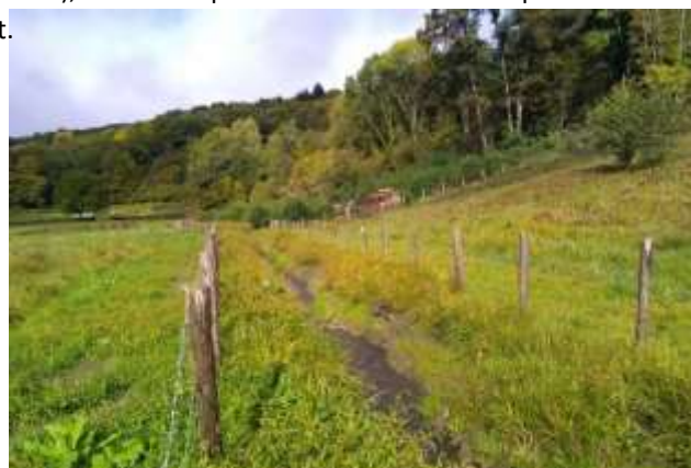
Le ruisseau des Vernes de Lyre après travaux : cette portion était jusqu'en 2018 couverte par un long busage
