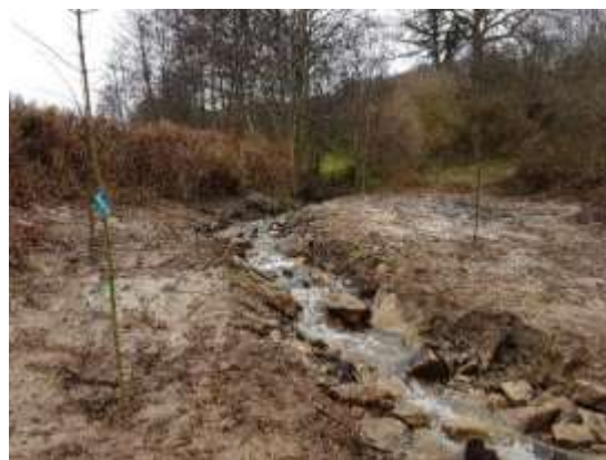
Le ruisseau des Naudiots à l'emplacement de l'ancien barrage de la prise d'eau juste après travaux
