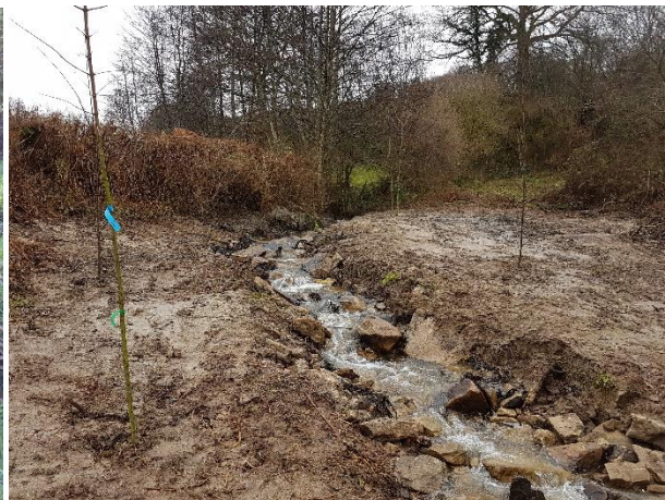
PHOTOGRAPHIE 1 : LE RUISSEAU DES NAUDIOTS A L'EMPLACEMENT DE L'ANCIEN BARRAGE DE LA PRISE D'EAU (PHOTO PRISE LE 13/12/17 APRES TRAVAUX)
