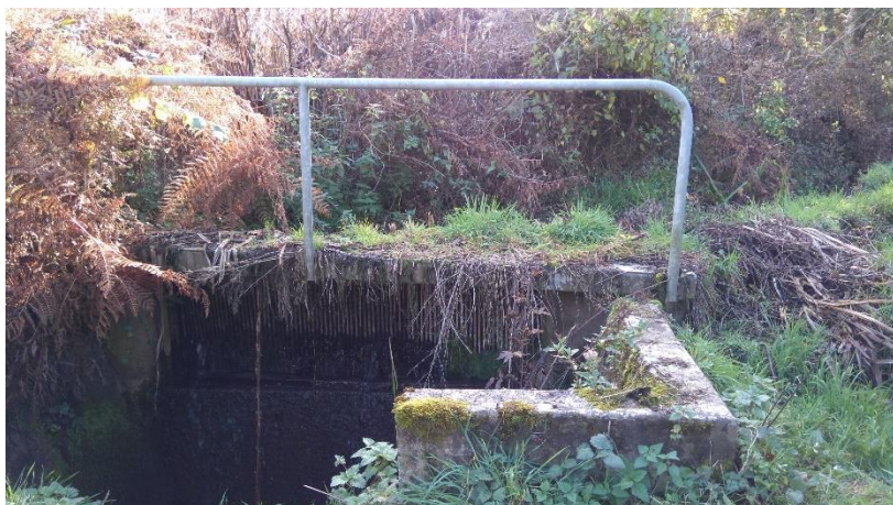
PHOTOGRAPHIE 2 : BARRAGE DE LA PRISE D'EAU IMPLANTÉ SUR LE RUISSEAU DES NAUDIOTS A MARMAGNE (PHOTO PRISE LE 30/10/17 AVANT TRAVAUX)
