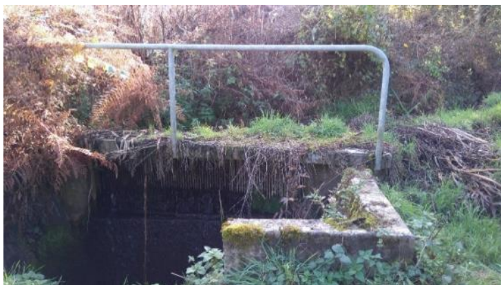
Barrage de la prise d'eau, implanté jusqu'en 2017 sur le ruisseau des Naudiots à Marmagne
