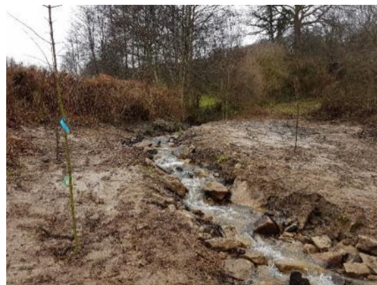
Le ruisseau des Naudiots à l'emplacement de l'ancien barrage de la prise d'eau juste après travaux
