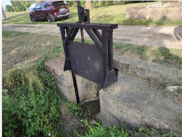
PHOTOGRAPHIE 9 : EXEMPLE D'UN OUVRAGE DE GESTION HYDRAULIQUE SUR LA SAONE
