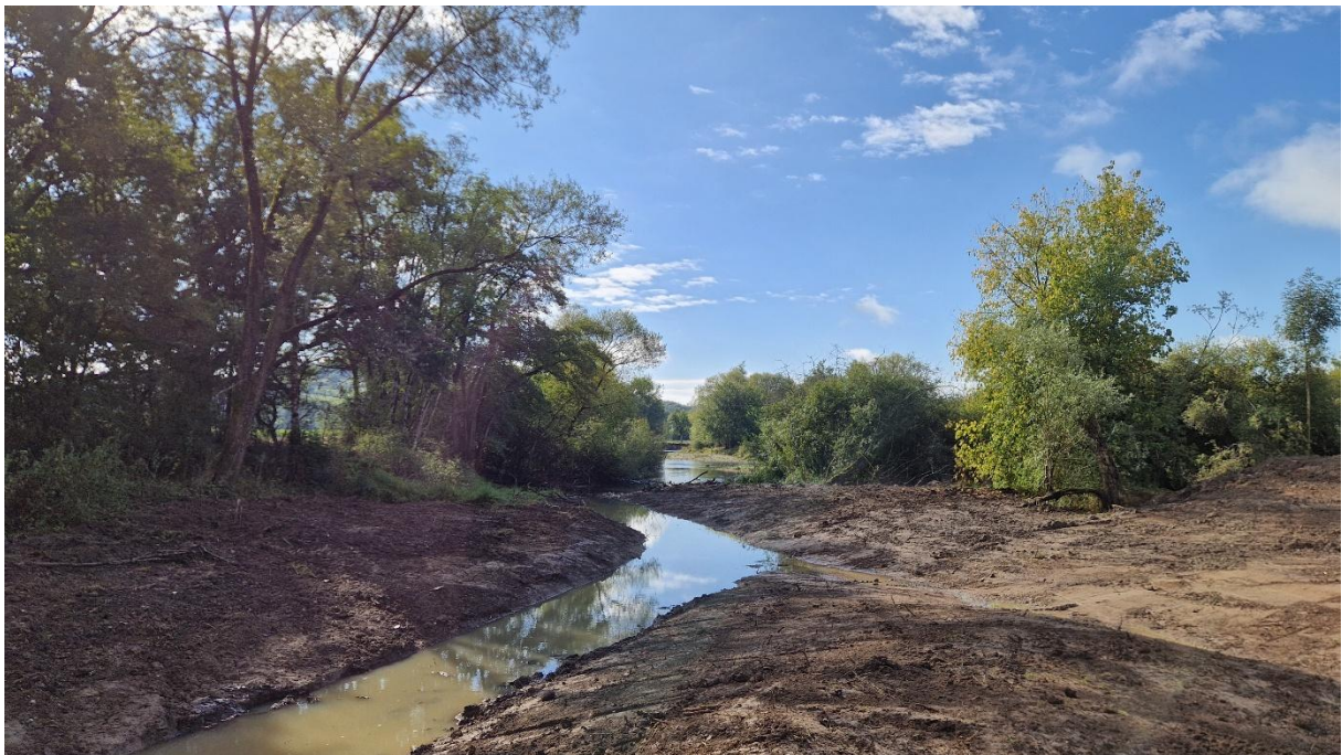
Photographie 3 et 4 : zone terrassée : le bras mort a été approfondi et les berges ont été remodelées en pente douce
