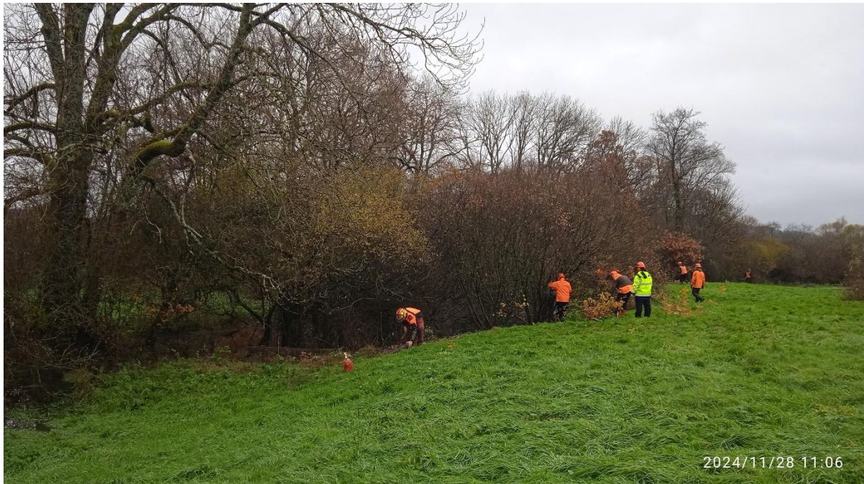
Photographie 2 : Coupe de la végétation arborée le long du bras mort
