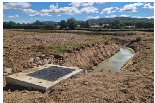
Travaux de terrassement d'un fossé et pose d'un ouvrage de gestion hydraulique
